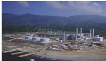
Ilijan Project 2 x 625 MW
